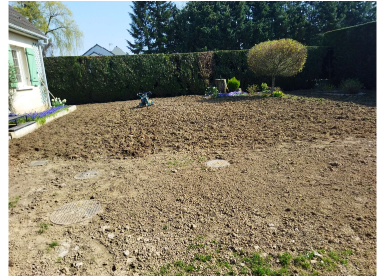
Après les travaux (Procès-verbal de réception du chantier)
