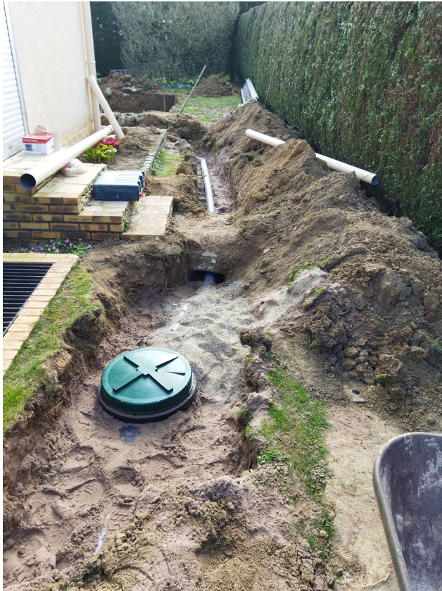
Pendant les travaux
