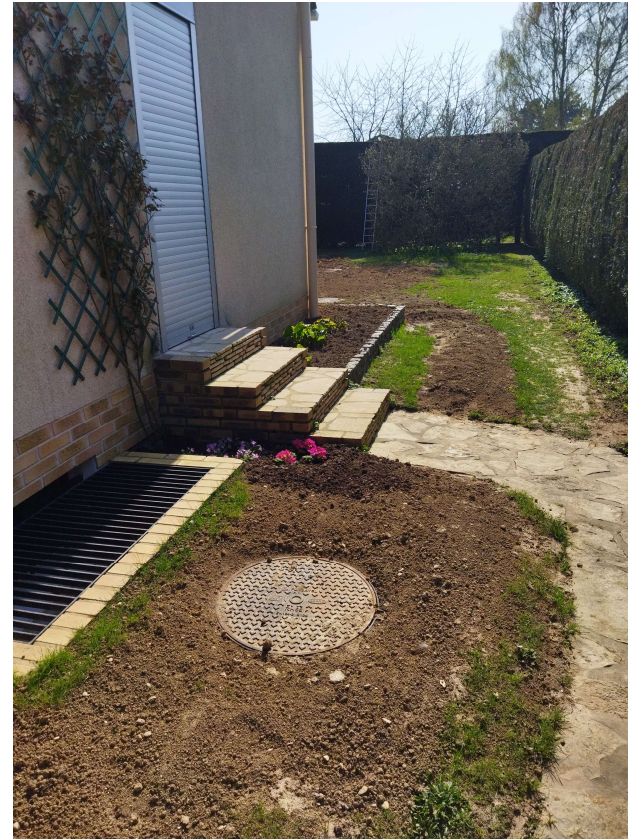
Après les travaux
