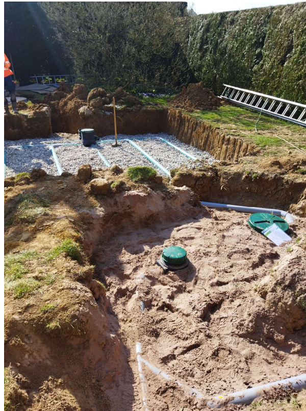
Pendant les travaux (Suivi de chantier du maître d'œuvre et contrôle du SPANC)
