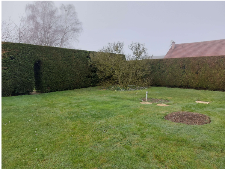
Avant les travaux (Constat d'huissier et piquetage des travaux)
