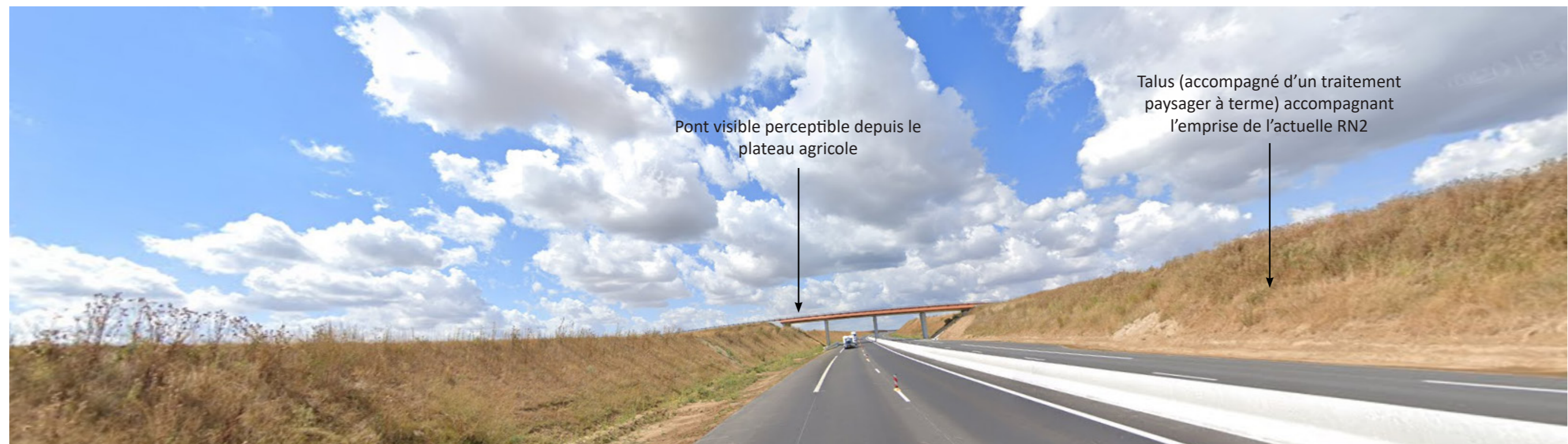
Depuis la RN2 déviée et mise à 2 x 2 voies, vue sur l'emprise occupée par l'infrastructure, décaissée par rapport au terrain naturel du plateau, et sur le pont réalisé pour assurer la liaison entre Gondreville et Ormoy-le-Davien
